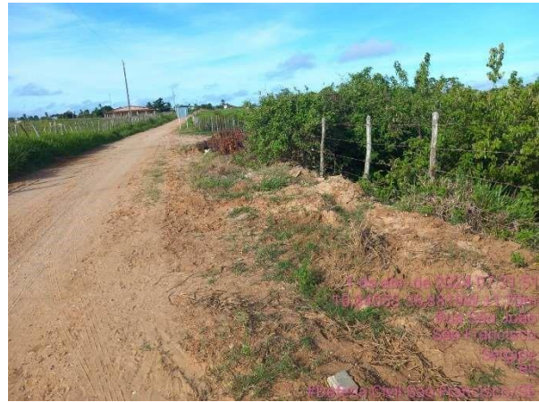
Figura 3 – Recuperação do leito da via
