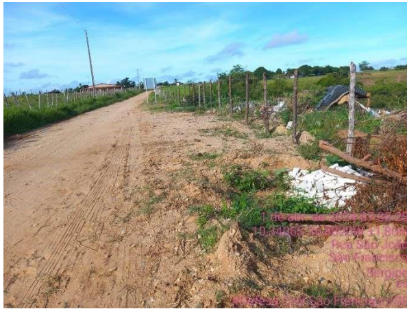
Figura 2 – Recuperação do Leito da Via
