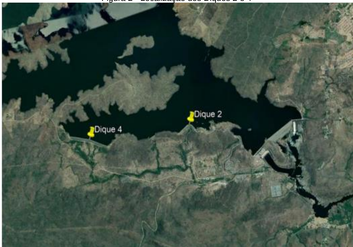
Figura 2 - Localização dos Diques 2 e 4
