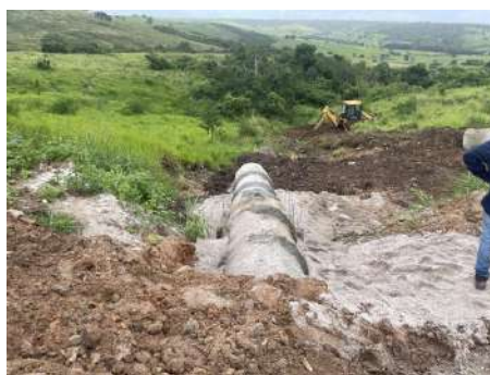
Foto 11: Execução da Rede de Drenagem
