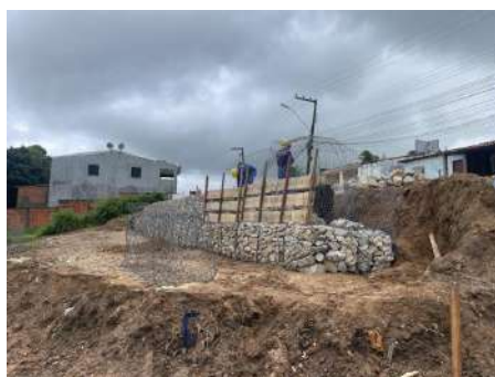
Foto 05: Execução de gabião
