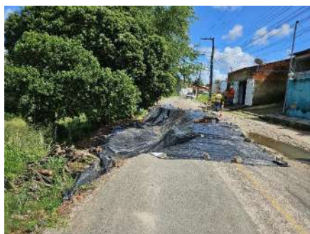
Imagem 6 - Avanço do Recalque
