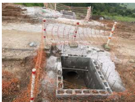
Foto 09: Execução de Boca de Lobo
