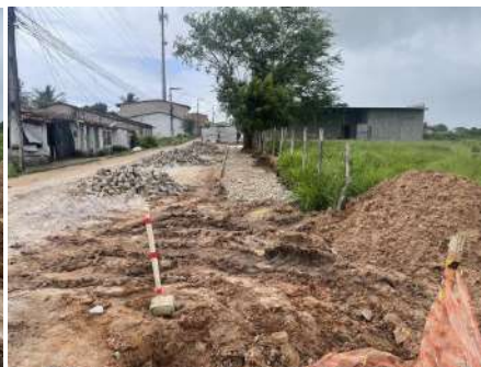
Foto 14: Recuperação do Pavimento
