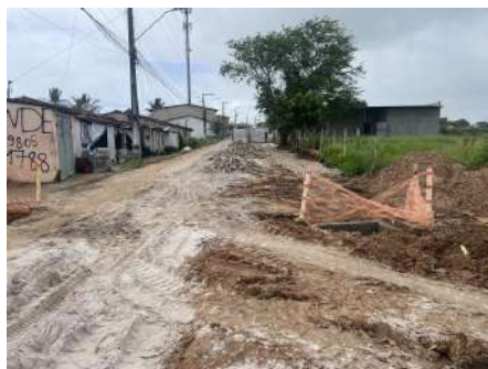
Foto 13: Recuperação do Pavimento
