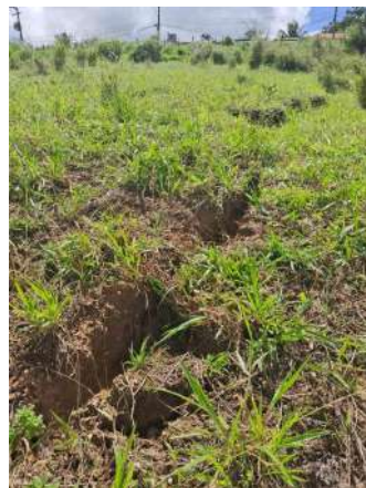
Imagem 14 – Aberturas no solo
