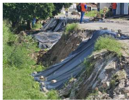
Imagem 7 - Avanço do Recalque
