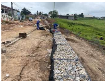
Foto 01: Execução de gabião
