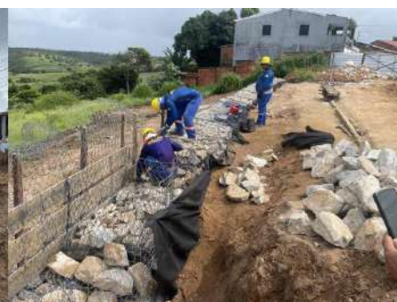
Foto 06: Execução de gabião
