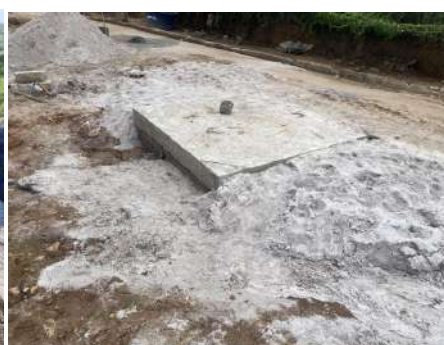
Foto 12: Execução de Caixa de Passagem
