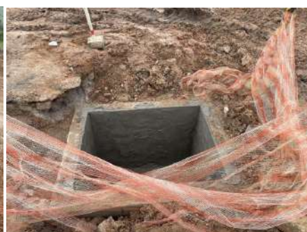
Foto 10: Execução de Boca de Lobo
