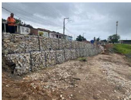
Foto 03: Execução de gabião
