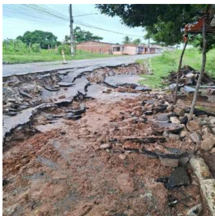
Imagem 4 - Avanço do Recalque
