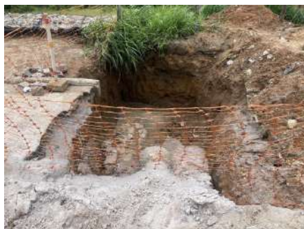
Foto 07: Execução de Boca de Lobo
