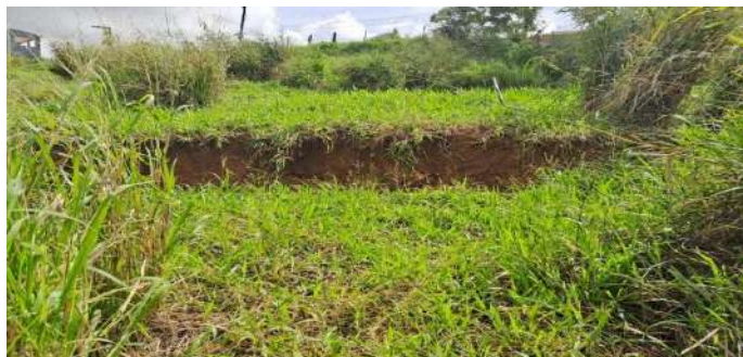
Imagem 13 - Desnível de solo
