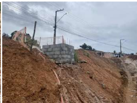
Foto 08: Execução de Boca de Lobo
