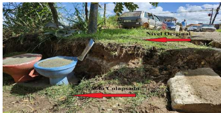
Imagem 17 - Níveis após deslizamento
