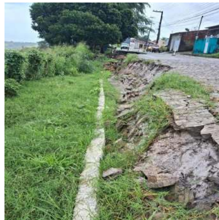
Imagem 5 - Avanço do Recalque
