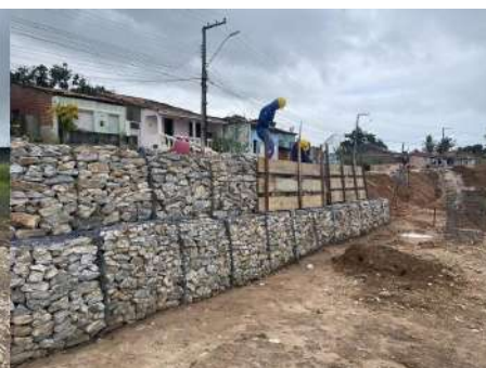
Foto 04: Execução de gabião
